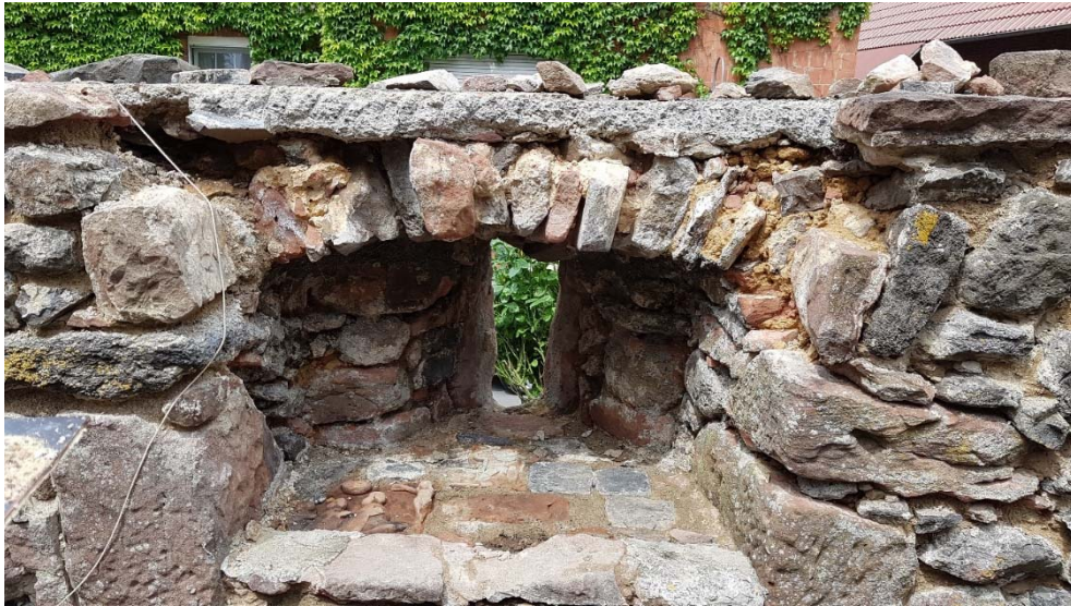
Eine Schlüsselscharte mit einer Segmentbogennische; in der Brüstung war eine Grabplatte versetzt.
