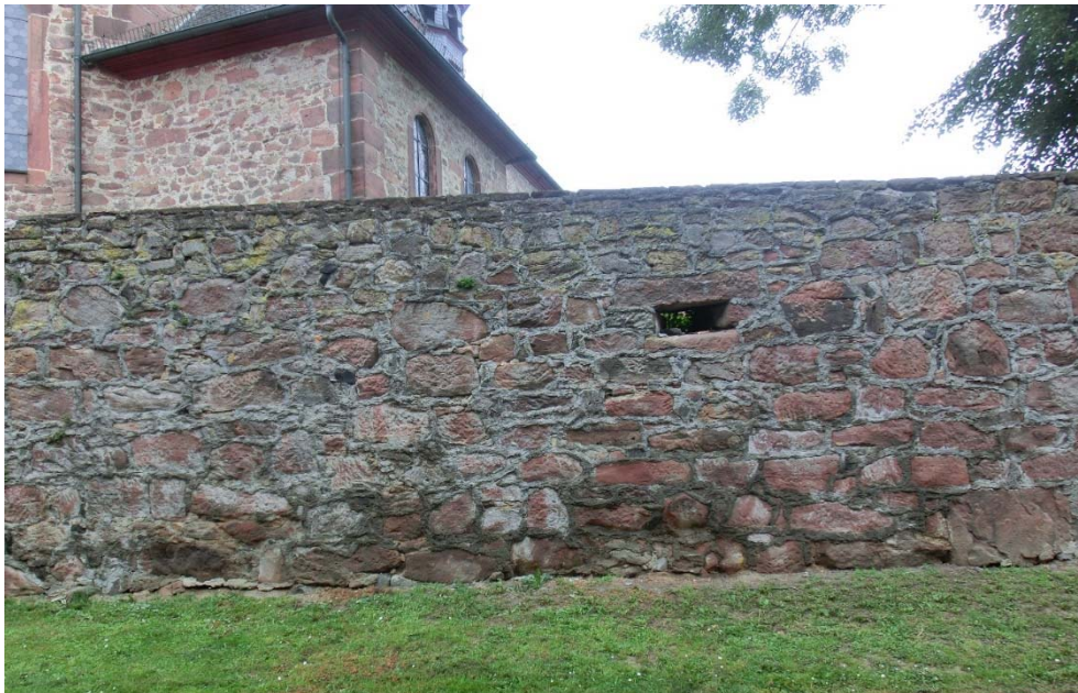
Ein Abschnitt der östlichen Wehrmauer vor Beginn der Maßnahme.
